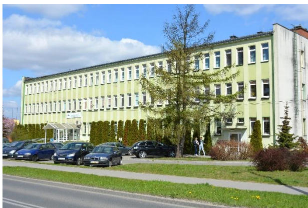
Siedziba PUP Chojnice przed remontem elewacji
