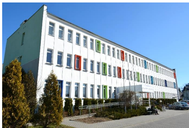
Siedziba PUP Chojnice po zakończeniu prac remontowych
